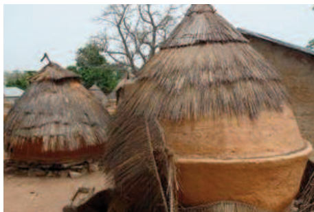
Photo 34 : Grenier en terre au sol
