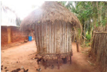
Photo 19 : Grenier en matériaux végétaux
